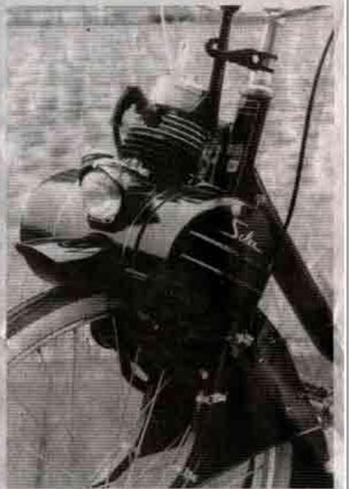
Het motortje dreef via een rol het voorwiel aan. Ontkoppelen gebeurde door het 7 kilo zware blokje met een hendel aan het luchtfilter omhoog te trekken en te vergrendelen.
